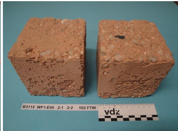
Bild 7-30 Beton WF1-E45 – CEM VI (S1-Q3), 1 FTW/Tag, Würfel 3 und 4 nach 102 FTW im Würfelverfahren
