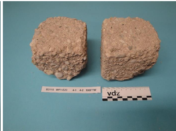
Bild 7-12 Beton WF1-E23 – CEM II/C-M (Q1-LL2), 2 FTW/Tag, Würfel 3 und 4 nach 100 FTW im Würfelverfahren
